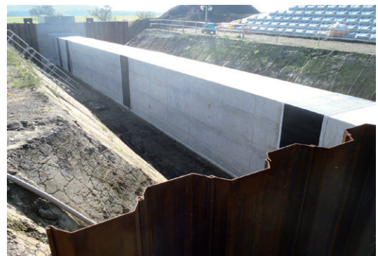
北海道開発局 札幌開発建設部 石狩川八幡樋門
