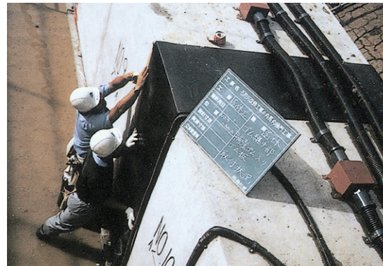
北海道開発局 石狩川開発建設部 長内樋門
