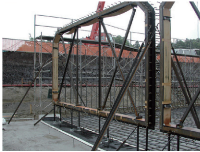
②可撓継手の設置
