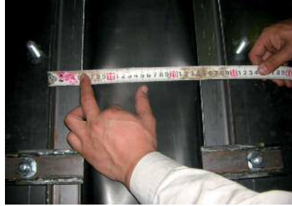
継手幅確認状況
