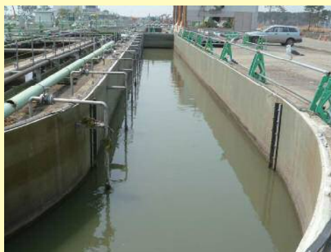
東日本大震災から宮城県の下水道施設の伸縮目地部を地震動から守ったRE50型
