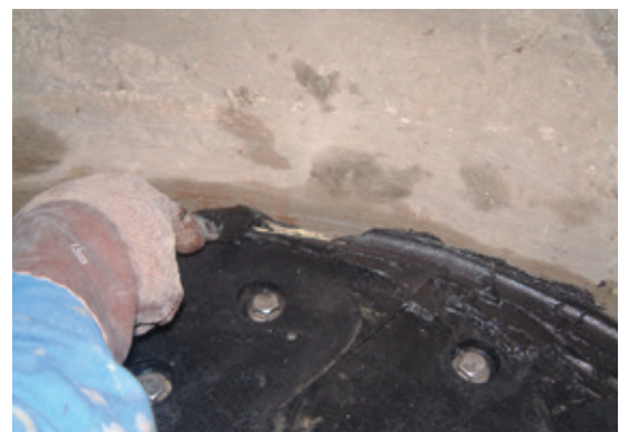
○コンクリート壁との境界面塗布
