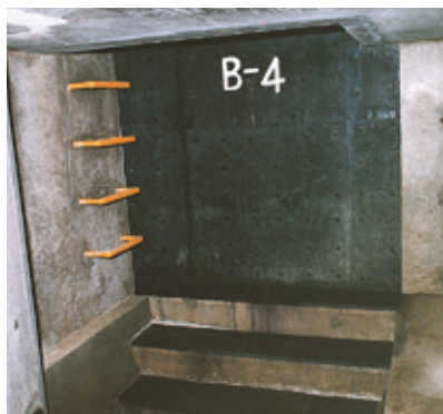
階段式落差工の保護
