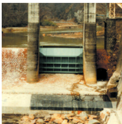
取水ダムのエプロン部
