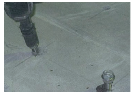
③アンカー打設
