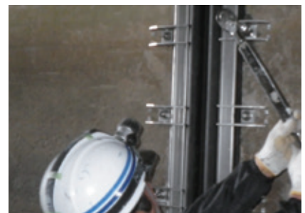
⑥押え板固定金具を設置
