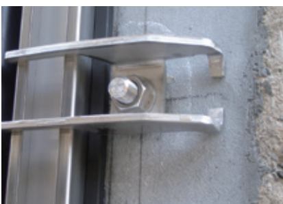
⑦押え板固定用金具の設置状況
