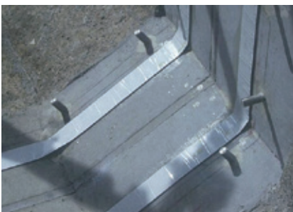
④止水材貼り付け
