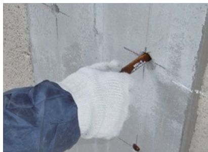
②穿孔、清掃後にカプセル挿入
