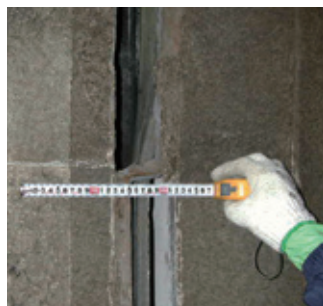
設置面の確認
