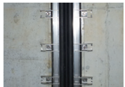
⑨施工完了
