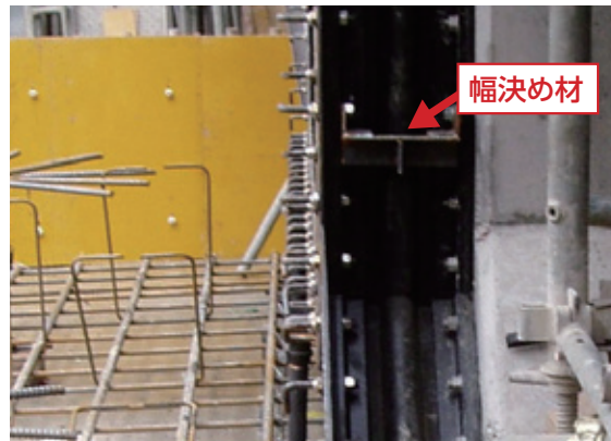
⑥新設側に別途手配の目地材と型枠を組み、コンクリートを打設し、打設後埋戻し前に幅決め材を撤去
