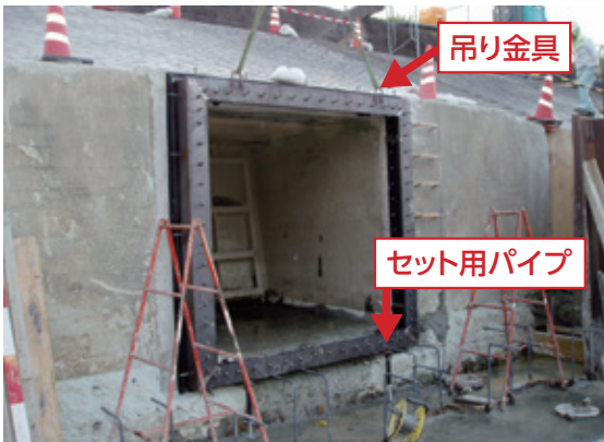
⑤継手据付状況（全景）
