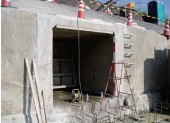
①既設コンクリートの下地処理
