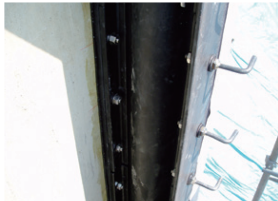
④新設側枠体をセットし、幅決め材で寸法固定
