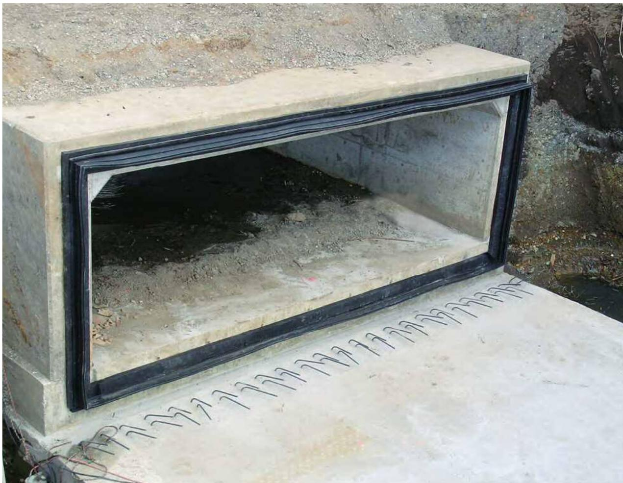
後付け式ゴム止水板180L型は、当社がわが国で初めて開発したゴム止水板「ブラックシール®」と、その後開発した可撓継手の技術を応用し、既設と新設の取り合い部に設置できる後付け式ゴム止水板です。
