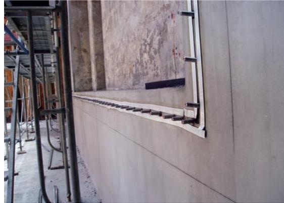
②既設コンクリート面に接着系アンカーを打設し、止水材をアンカーの両側に貼付け
