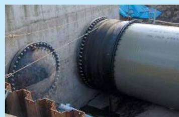
FRPM管(強化プラスチック複合管)との接続例
