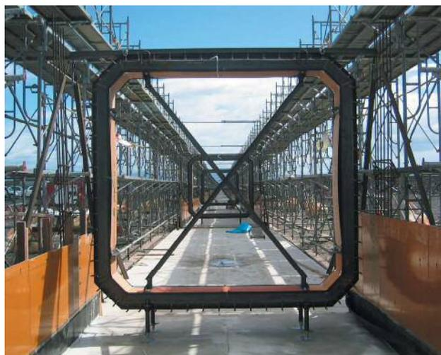
アンダーパス・共同溝の耐震化ならびに不同沈下対策を目的としたビーシージョイントの採用事例
