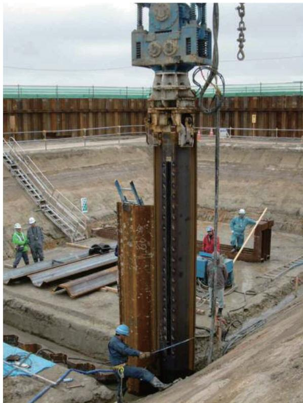
ハット形鋼矢板は薄肉大断面形状でありながら、施工性に優れ、信頼性が高く経済的な壁体を構築できる鋼矢板です。
