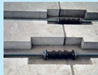
硬質ポリ塩化ビニル管との接続例
