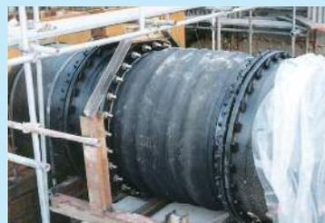
DCIP(ダクタイル鋳鉄管)との接続例
