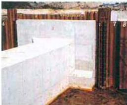
従来の剛支持樋門に採用されている鋼矢板用可撓継手で、護岸用も製作しています。
