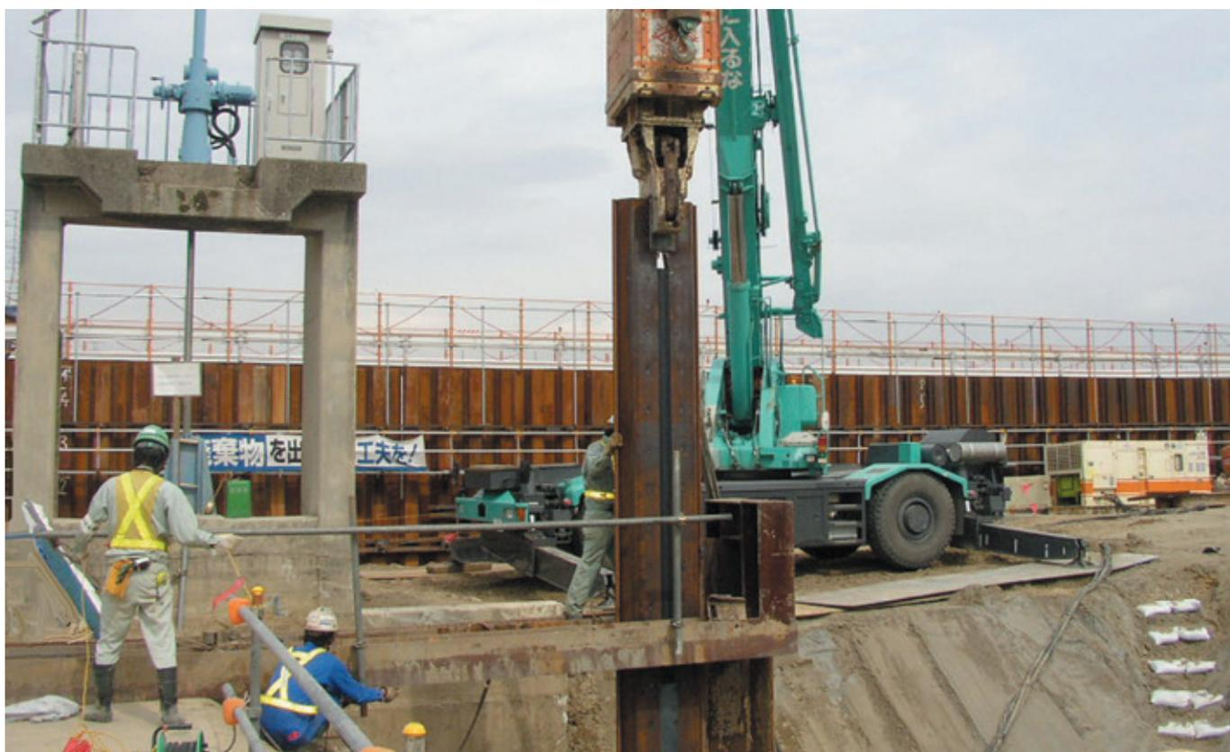
堤防の不等沈下等の変位吸収と負の周面摩擦力の影響を遮断する目的で鋼矢板用可とう継手を設けるよう構造技術基準が定められており、フレックスパイルは全国の樋門、樋管水門、護岸工事に幅広く採用されています。
