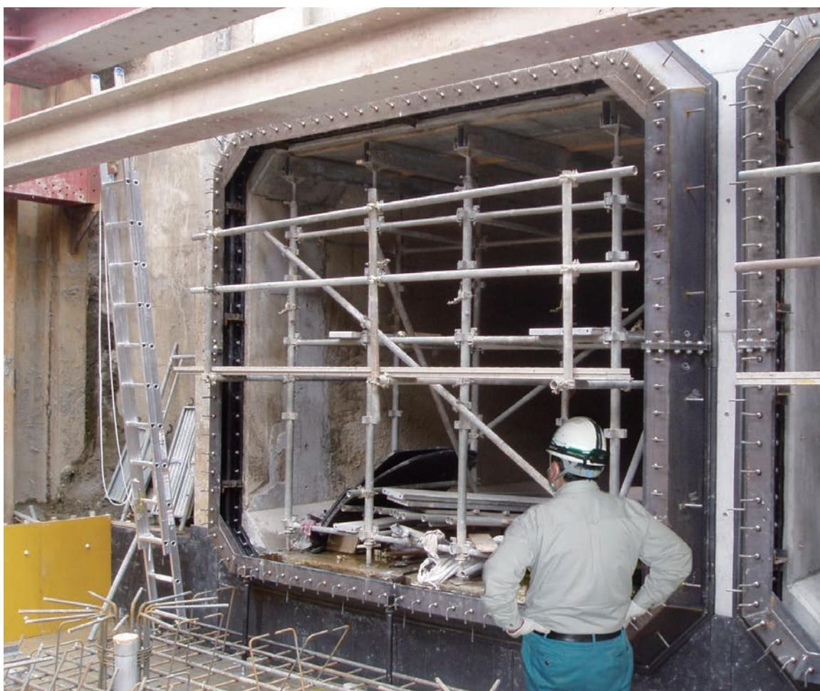
各種水利・水処理施設、地下鉄、共同溝、洞道、地下通路等のコンクリート構造物において、地盤沈下や地震変位への対応を目的とし1997年に既設と新設の取り合い部に設置できる横締め型のビーシージョイントG型を開発しました。以来、全国の水利・水処理施設や共同溝等に沈下対策、地震対策、漏水対策で多数採用されています。
