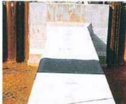
柔構造樋門継目用耐土圧板で、施工性と経済性を考慮したゴム板タイプの耐圧ゴムプレートです。
