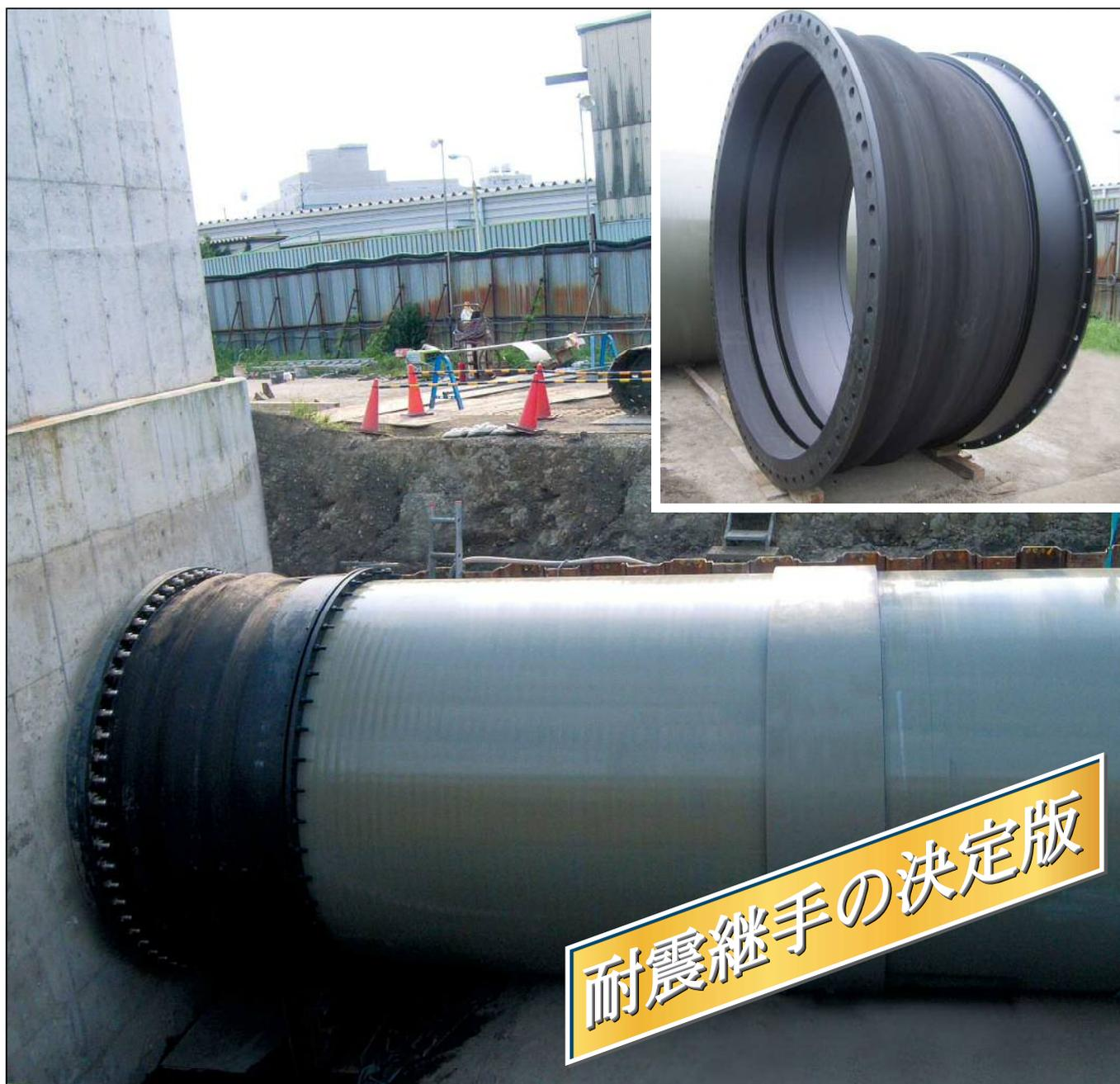
構造物とFRPM管との取合部に設置されたスーパージョイント口径3000mm
