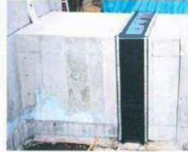
柔構造樋門継目用耐土圧板で、ボルトで函体に固定する波型タイプの耐圧ゴムプレートです。
