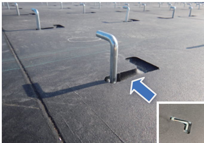
収納されたL型アンカーボルト
