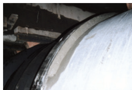
【無収縮モルタルコーキングの施工例】
