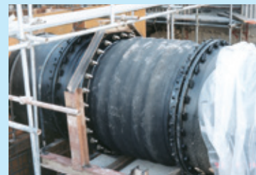
DCIP(ダクタイル鋳鉄管)との接続例
