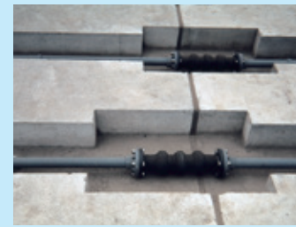
硬質ポリ塩化ビニル管との接続例
