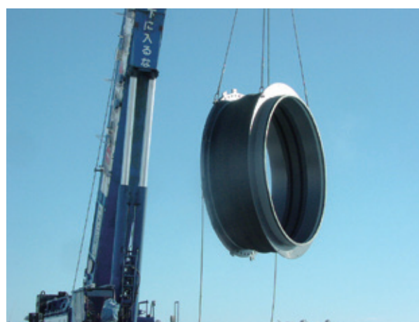
【口径3000mm 吊り降ろし状況】
