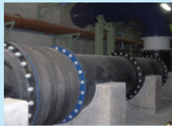
ダクタイル鋳鉄管との接続例
