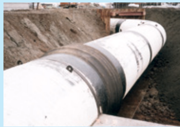
鋼管との接続例(1)
