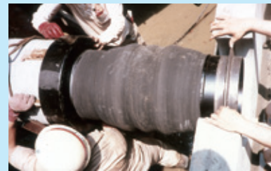
片側壁埋め込みタイプの接続例
