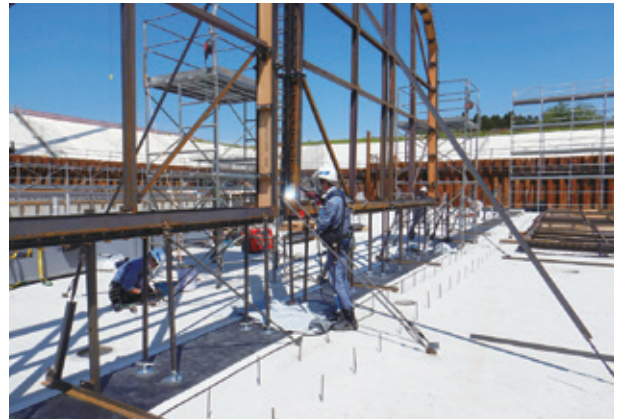
④ターンバックル、L鋼等を用いての仮支保工
