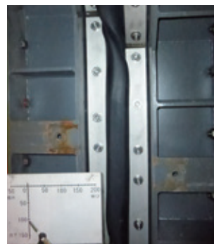
沈下量 100mm確認
