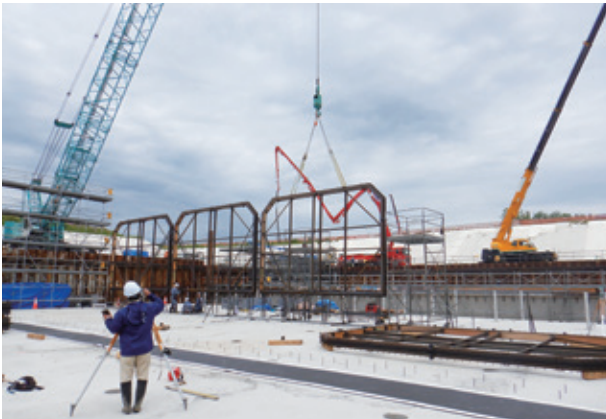
③レベル測量し、設置高さを確認
