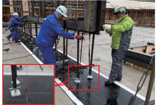
②下げ振りを利用し、ベースジャッキを微調整
