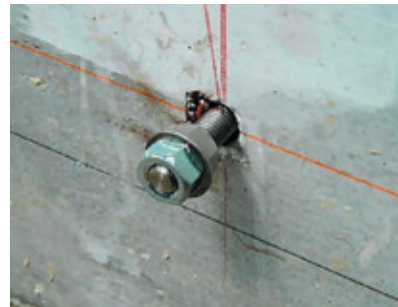
(アンカーボルト打設状況)
