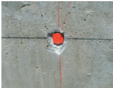
(カプセル挿入状況)
