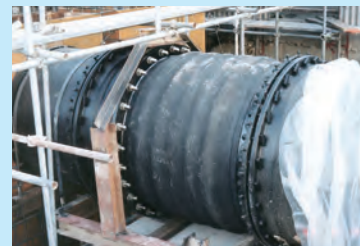
DCIP(ダクタイル鋳鉄管)との接続例
