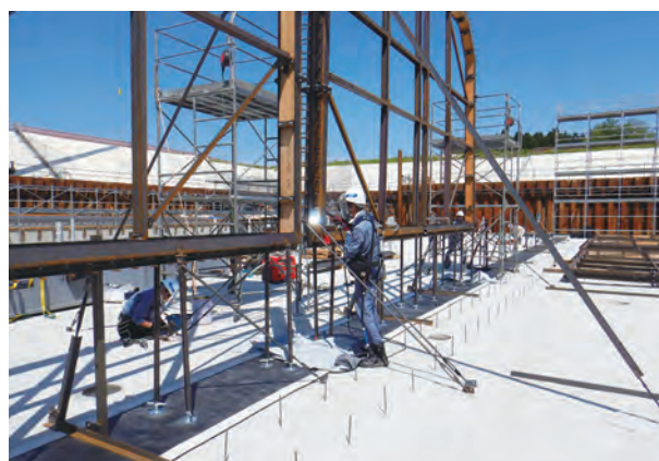
④ ターンバックル、L鋼等を用いての仮支保工
