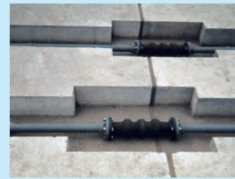
硬質ポリ塩化ビニル管との接続例
