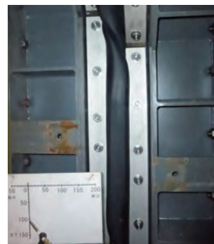
沈下量 100mm確認
