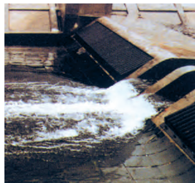
河川構造物の洗掘防止
