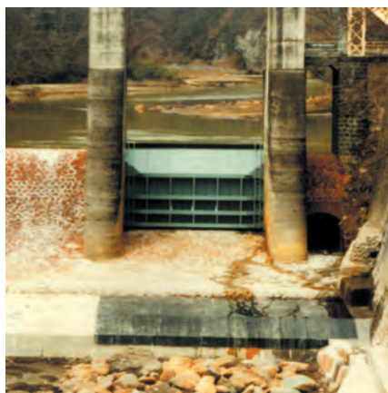
取水ダムのエプロン部
