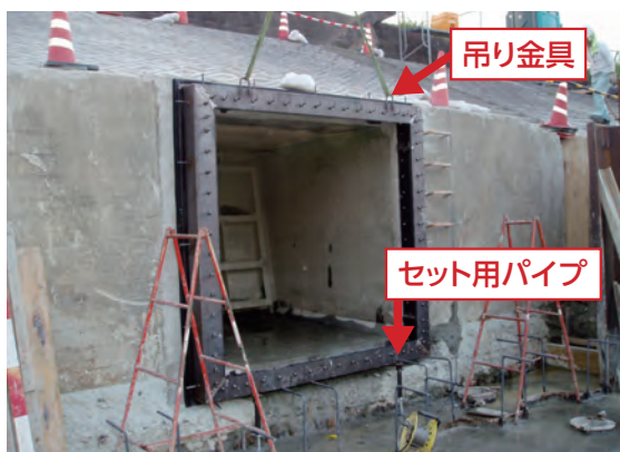
⑤継手据付状況（全景）
