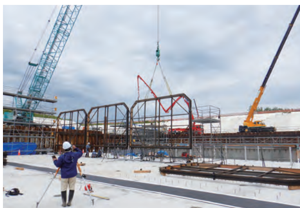
③ レベル測量し、設置高さを確認
