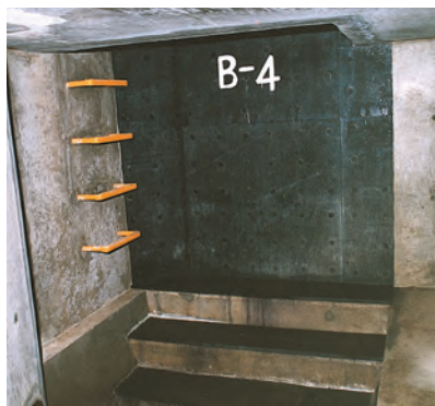
階段式落差工の保護
