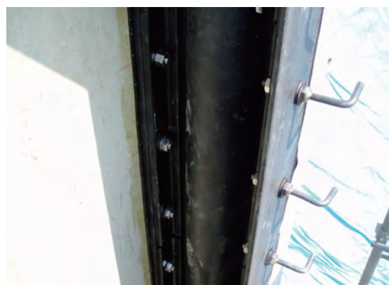
④新設側枠体をセットし、幅決め材で寸法固定
