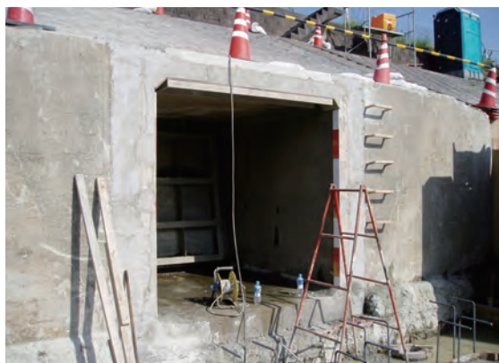
①既設コンクリートの下地処理
