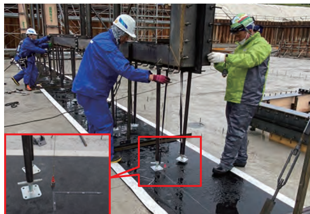
② 下げ振りを利用し、ベースジャッキを微調整
