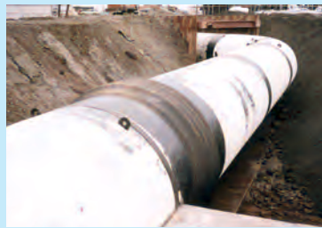
鋼管との接続例 (1)
