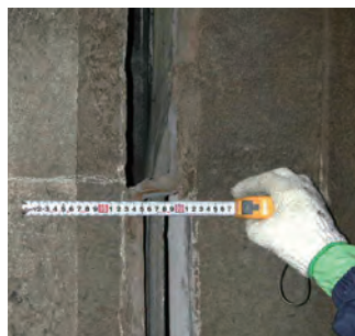
設置面の確認
