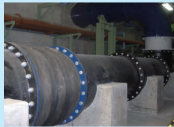
ダクタイル鋳鉄管との接続例
