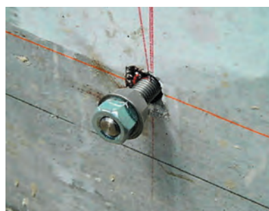
（アンカーボルト打設状況）
