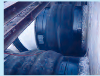
鋼管との接続例 (2)
