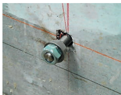
（アンカーボルト打設状況）
