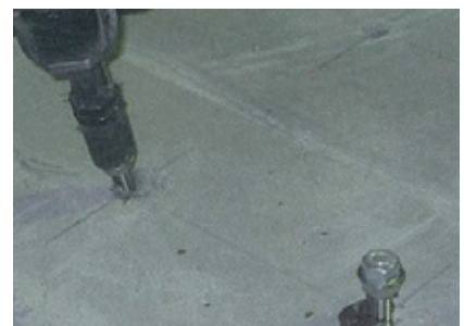
③アンカー打設
