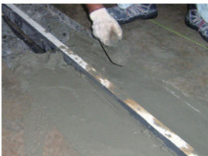
④樹脂モルタル仕上げ
