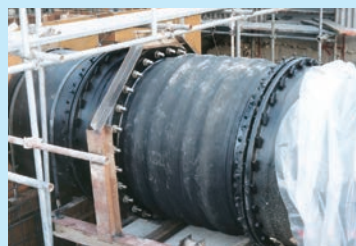
DCIP(ダクタイル鋳鉄管)との接続例
