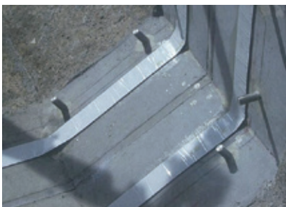
④止水材貼り付け
