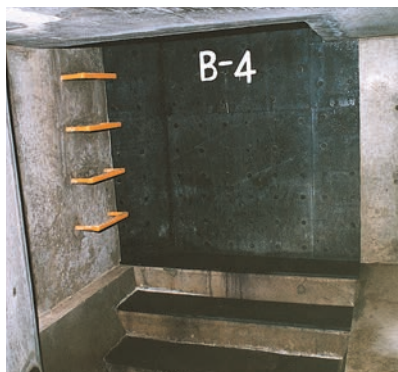
階段式落差工の保護
