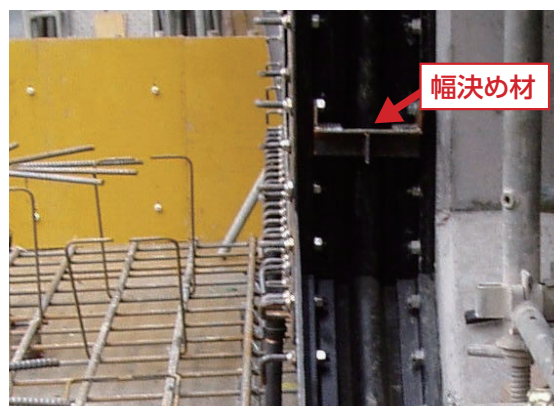
⑥新設側に別途手配の目地材と型枠を組み、コンクリートを打設し、打設後埋戻し前に幅決め材を撤去
