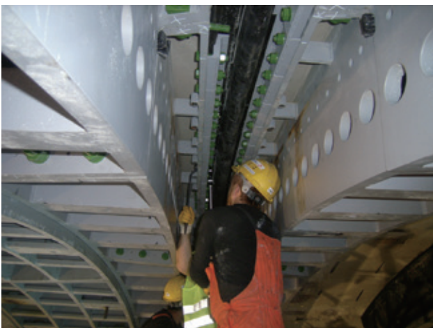
止水ゴムの取り付け
