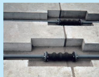
硬質ポリ塩化ビニル管との接続例
