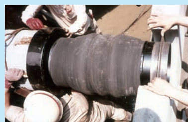
片側壁埋め込みタイプの接続例
