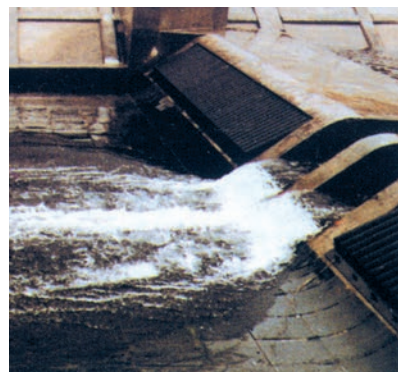
河川構造物の洗掘防止
