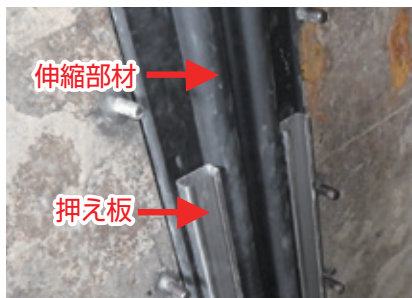
⑤伸縮部材を押え板で固定
