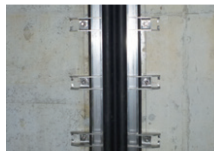
⑨施工完了
