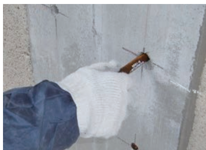
②穿孔、清掃後にカプセル挿入
