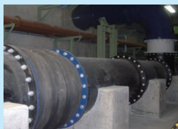
ダクタイル鋳鉄管との接続例
