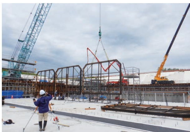
③レベル測量し、設置高さを確認
