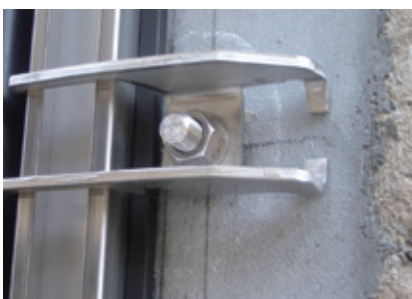
⑦押え金具の設置状況
