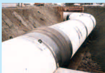
鋼管との接続例 (1)
