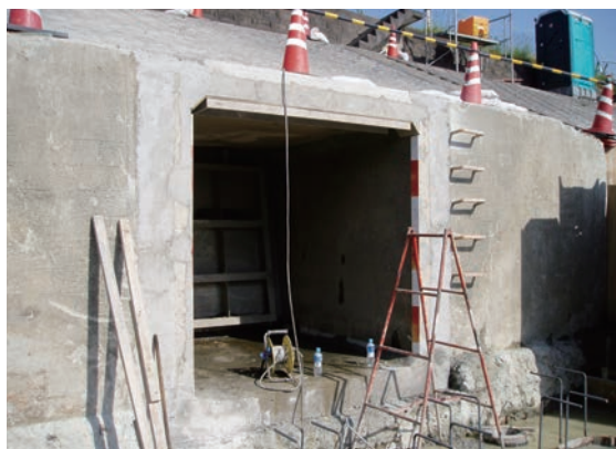
①既設コンクリートの下地処理
