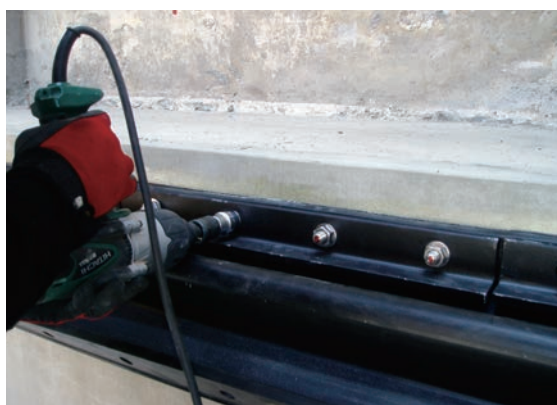
③伸縮部材をボルト締め（トルクレンチで確認）
