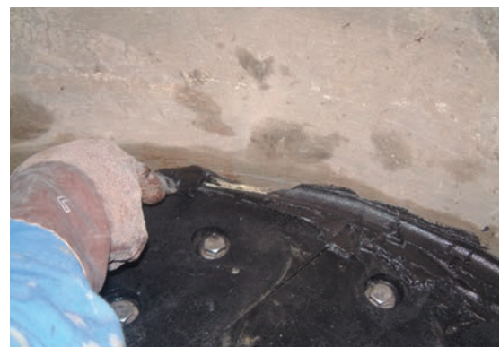
○コンクリート壁との境界面塗布
