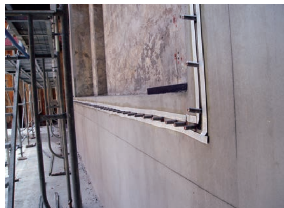
②既設コンクリート面に接着系アンカーを打設し、止水材をアンカーの両側に貼付け
