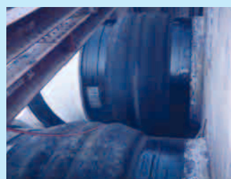
鋼管との接続例 (2)
