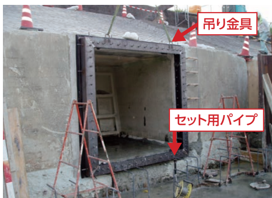
⑤継手据付状況（全景）
