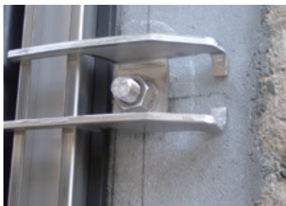
⑦押え金具の設置状況
