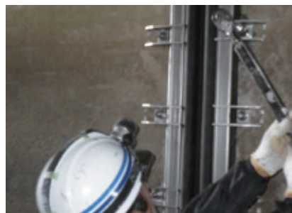
⑥押え金具を設置
