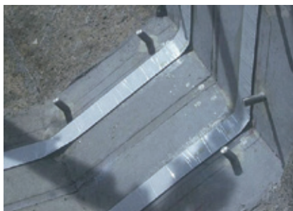
④止水材貼り付け
