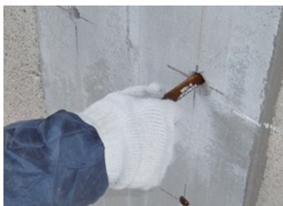
②穿孔、清掃後にカプセル挿入
