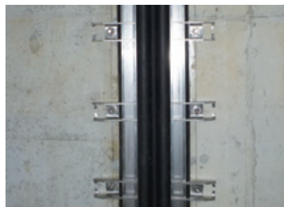
⑨施工完了
