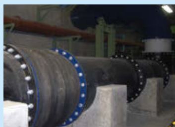
ダクタイル鋳鉄管との接続例
