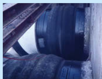
鋼管との接続例 (2)
