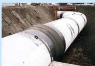
鋼管との接続例 (1)
