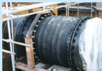
DCIP(ダクタイル鋳鉄管)との接続例
