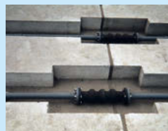
硬質ポリ塩化ビニル管との接続例
