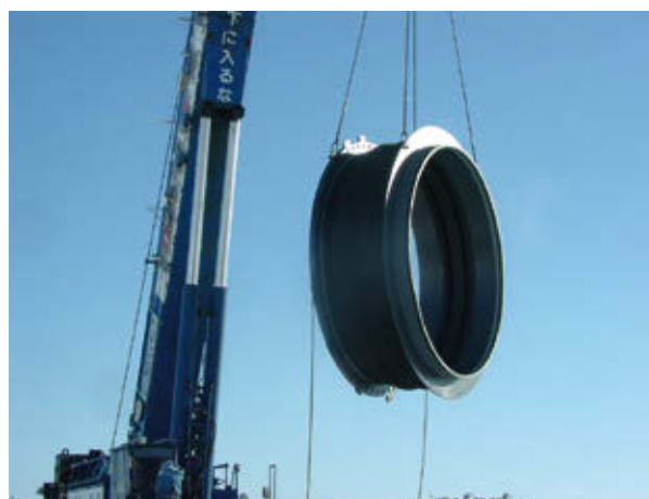
【口径3000mm 吊り降ろし状況】
